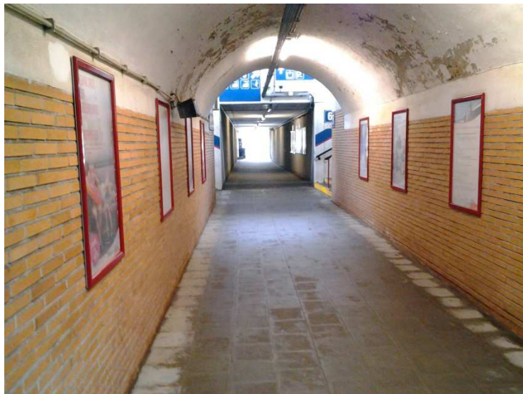
Vilvorde - Tunnel sous voies
