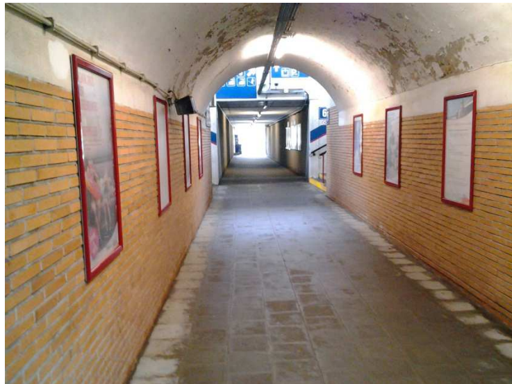
Vilvoorde – Tunnel onder spoorwegen
